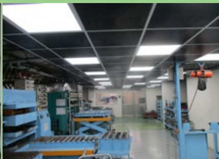
生產區 T5 燈具更換成 LED 燈具
